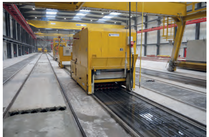
Bétonnage de dalles alvéolées par la machine d'extrusion à l'usine de Malle
