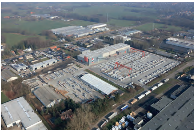
Vue aérienne de l'usine Fingo à Malle (Belgique)
